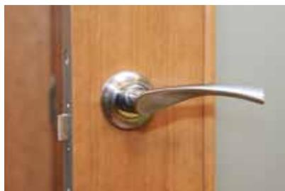
Puertas de paso macizas, de 30 mm. de espesor, con vidrio templado las del salón, cocina y pasillo. Acabados de los mismos diseños que el mobiliario. Manillas de acero inoxidable.
